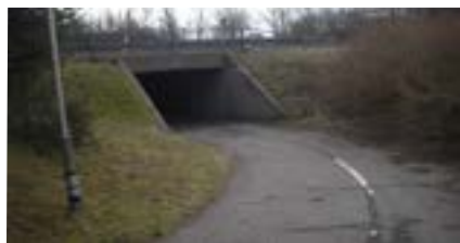
Tunnel under Ålborgvej
